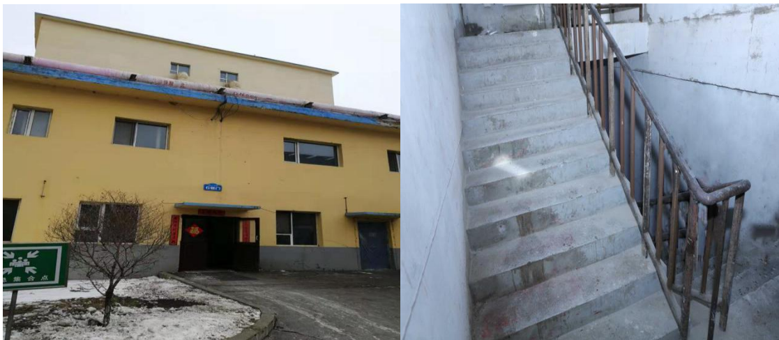
图一 长丝八车间 6 号门及三楼楼梯间
