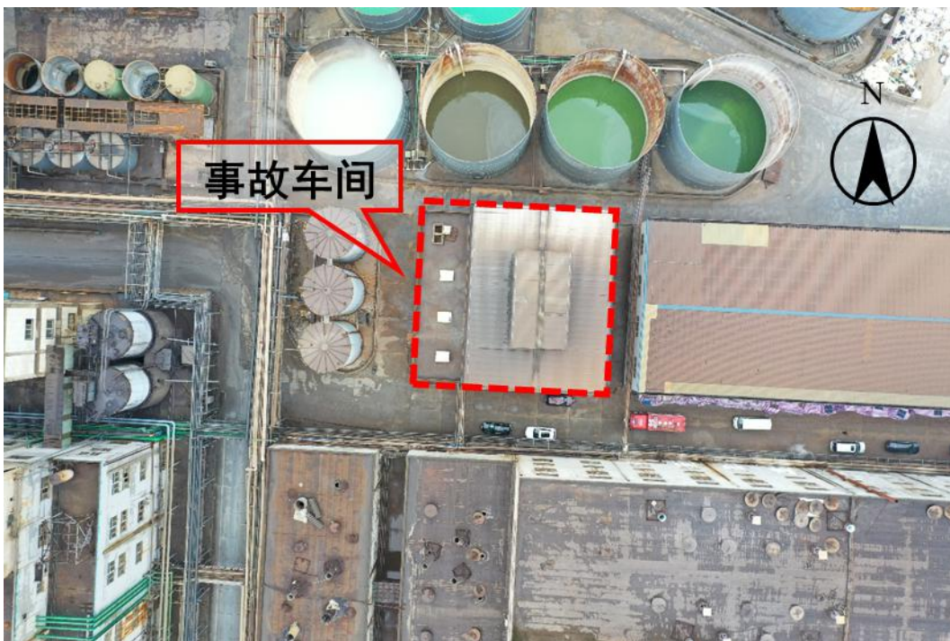
图 3 事故车间航拍图
