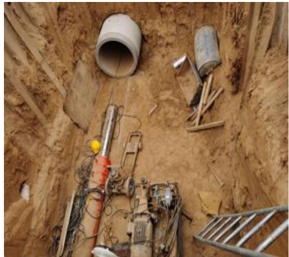
顶管施工现场
