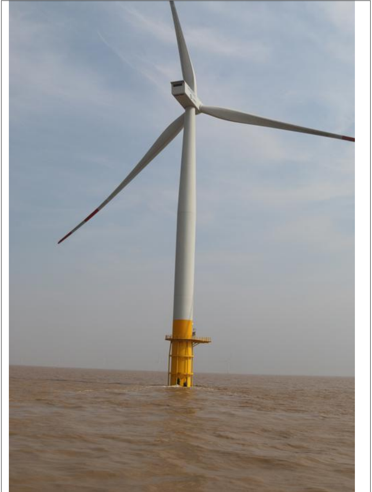
图 14：38 号风机塔全貌
