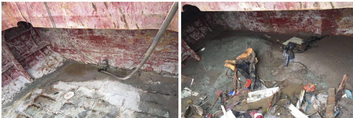
图 11: 现场勘验部分照片 (4)
