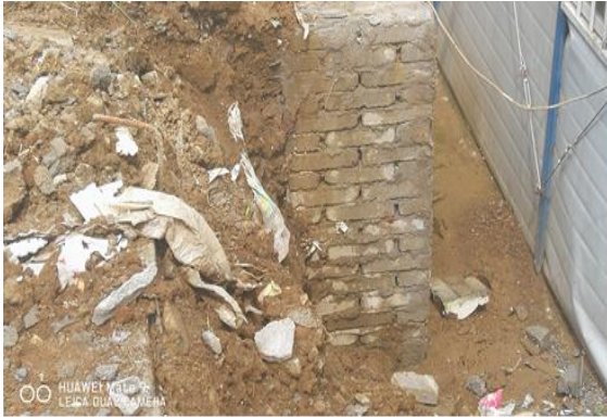
图 8 围墙内侧回填建筑垃圾及粘土、外侧为活动板房
