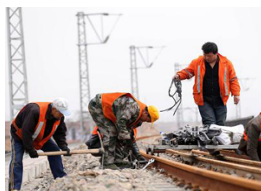
黄韩侯铁路侯西段电气化复线施工
